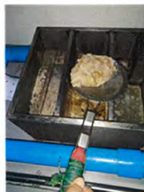
ภาพถ่ายที่ 2.2-20 เจ้าหน้าที่ตักไขมันในบ่อดักไขมัน (Grease trap tank)
