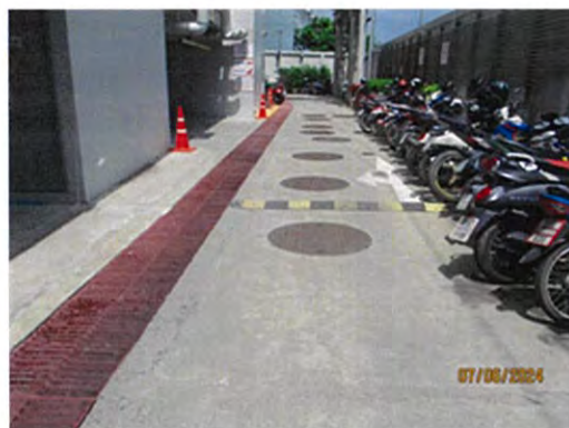
ภาพถ่ายที่ 2.2-65 ตะแกรงดักขยะที่บ่อตรวจสอบภาพน้ำ
