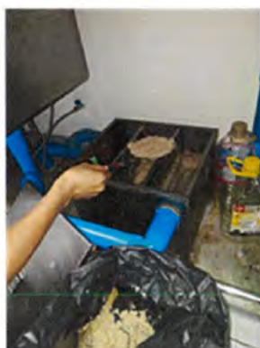
ภาพถ่ายที่ 2.2-20 เจ้าหน้าที่ตักไขมันในบ่อดักไขมัน (Grease trap tank)
