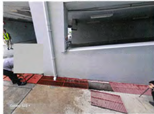
ภาพถ่ายที่ 2.2-67 การล้างทำความสะอาดรางระบายน้ำ
