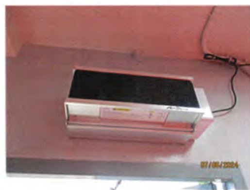
ภาพถ่ายที่ 2.2-53 การติดตั้งแสง UV เพื่อฆ่าเชื้อโรค
